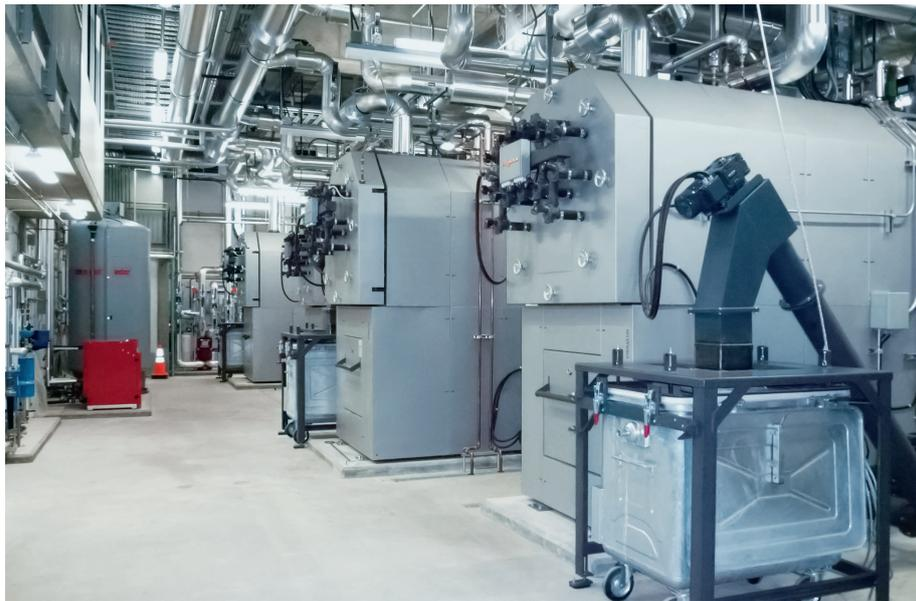
Die Kombination des bewegten Vorschubrostes mit der bewährten Feuermulde und dem fallenden Außenrost vereint beim Pyroflex UF die Vorteile der Vorschubrostfeuerung mit der Unterschubfeuerung auf optimale Weise. Eine Einschubschnecke führt den Holzbrennstoff in die Feuermulde, wo er vorgetrocknet wird. Auf dem Außenrost und dem bewegten Vorschubrost wird der Brennstoff vollständig entgast. Danach werden die Holzgase unter geregelter Zufuhr von Sekundärluft verbrannt.
